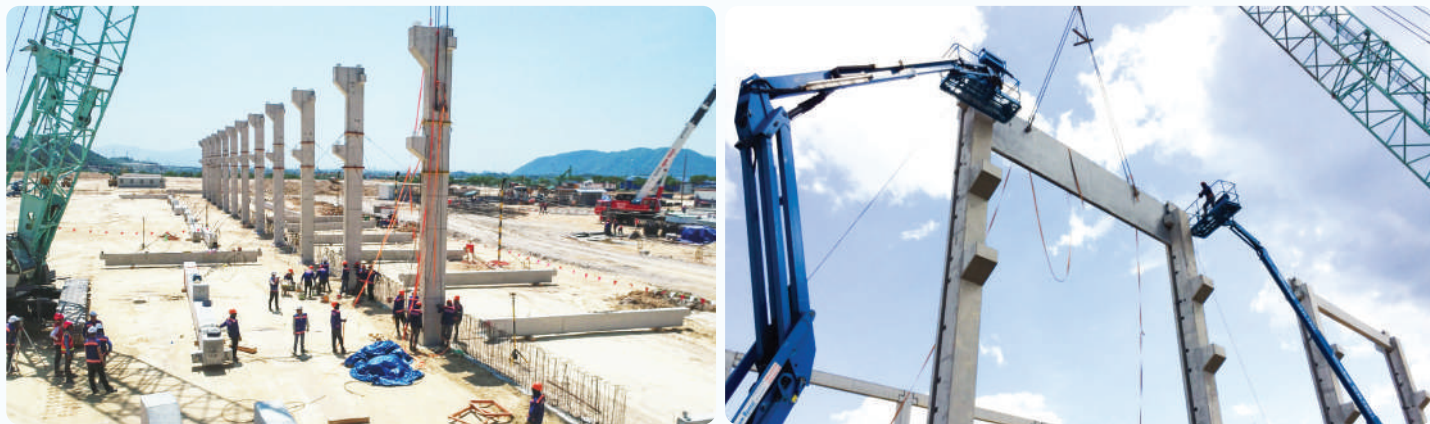
拼接混凝土柱、墙板组装
